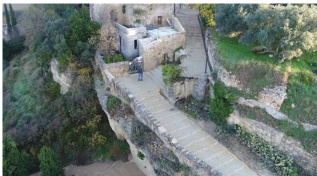
Illustration : Restauration des escaliers du château, commune de Cabrières d'Aigues
